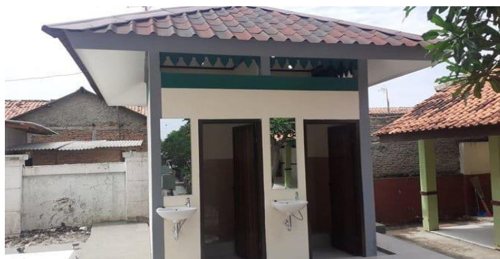
Gambar 2. Bukti Pengadaan sanitasi toilet
