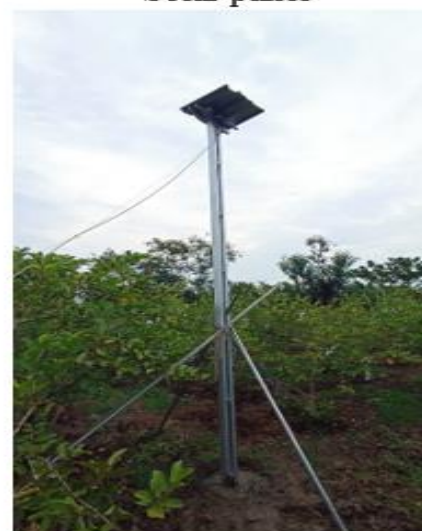
Pemasangan Alat Ultrasoni
