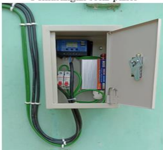
Pemasangan Control box
