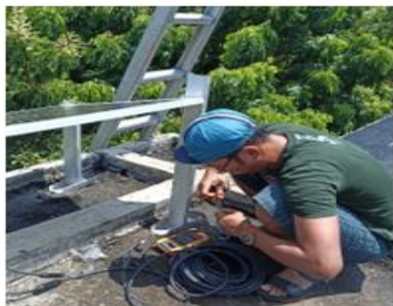
Pemasangan solar panel
